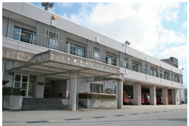
富山県東部消防組合消防本部庁舎
