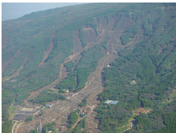
伊豆大島上空からの被害状況（さいたま市消防局提供）
