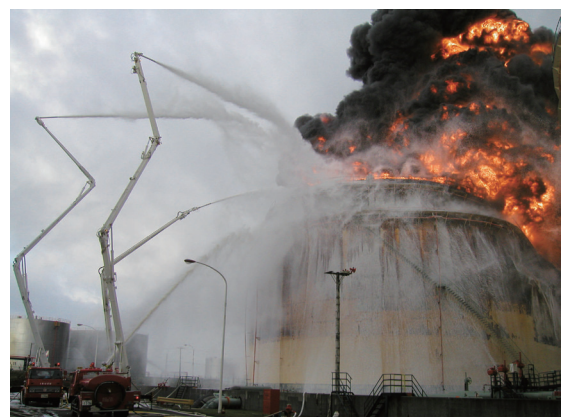
十勝沖地震でのタンク火災
