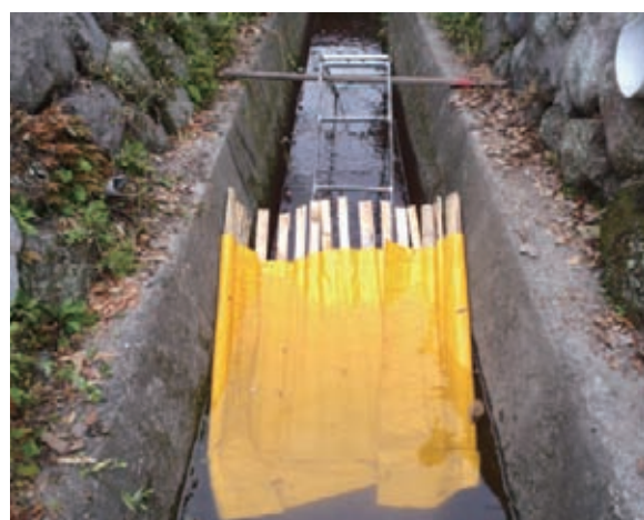
＜使用方法3＞ 「すのこ」を設置し完成
