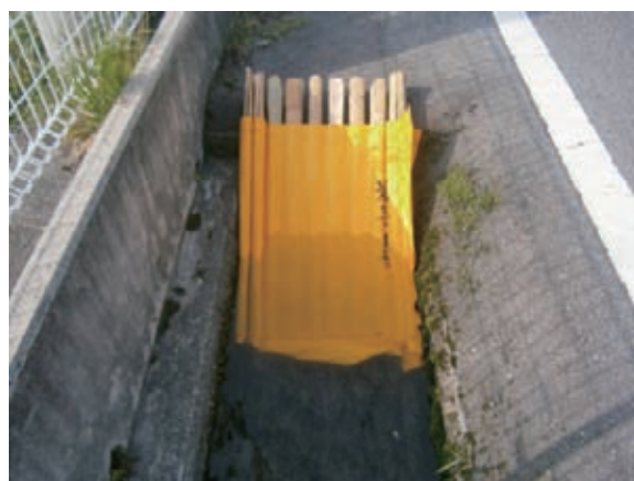
＜使用方法1「すのこ」設置後＞ 「すのこ」を川幅に合わせて畳んで設置しただけで、 20センチ程度の水深が50センチまで増加
